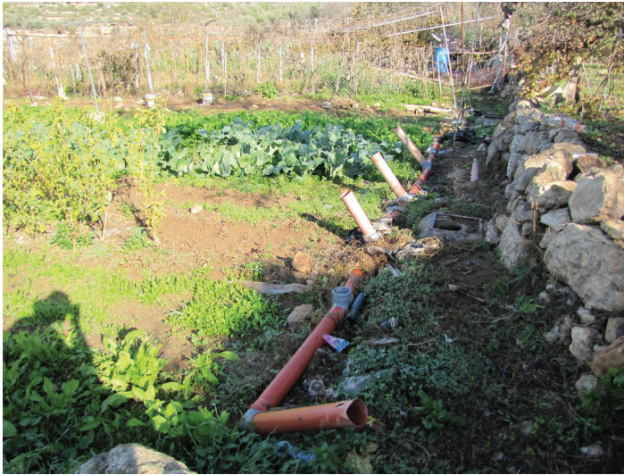
איור 10: שימוש בצינורות PVC להשקיית החלקה
